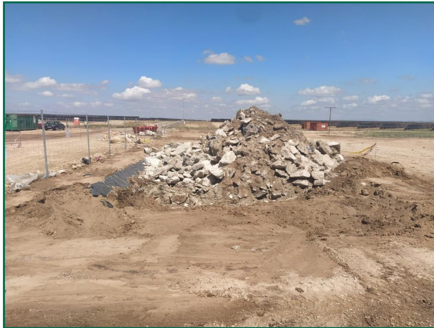
Fotografía 10. Zona de lavado de hormigón en proceso de retirada.
