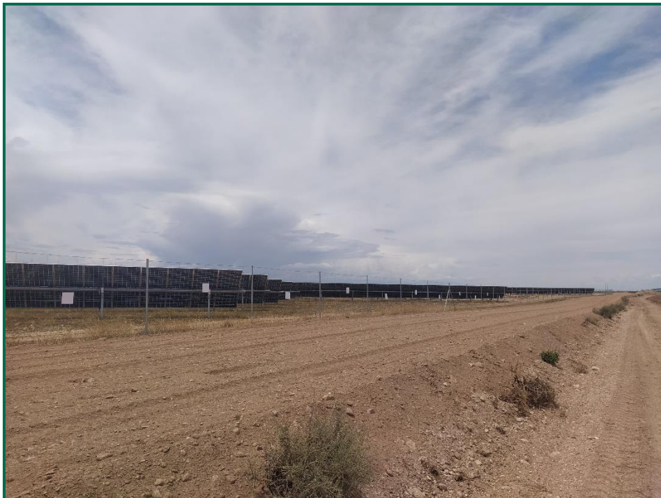
Fotografía 4. Acopio de tierra ya extendida.
