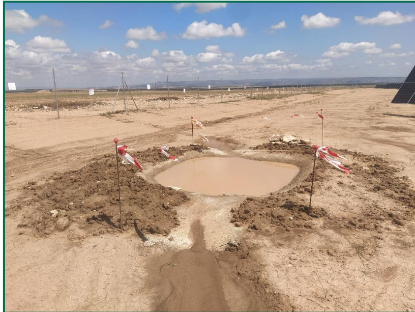
Fotografía 7. Basete ya construido.
