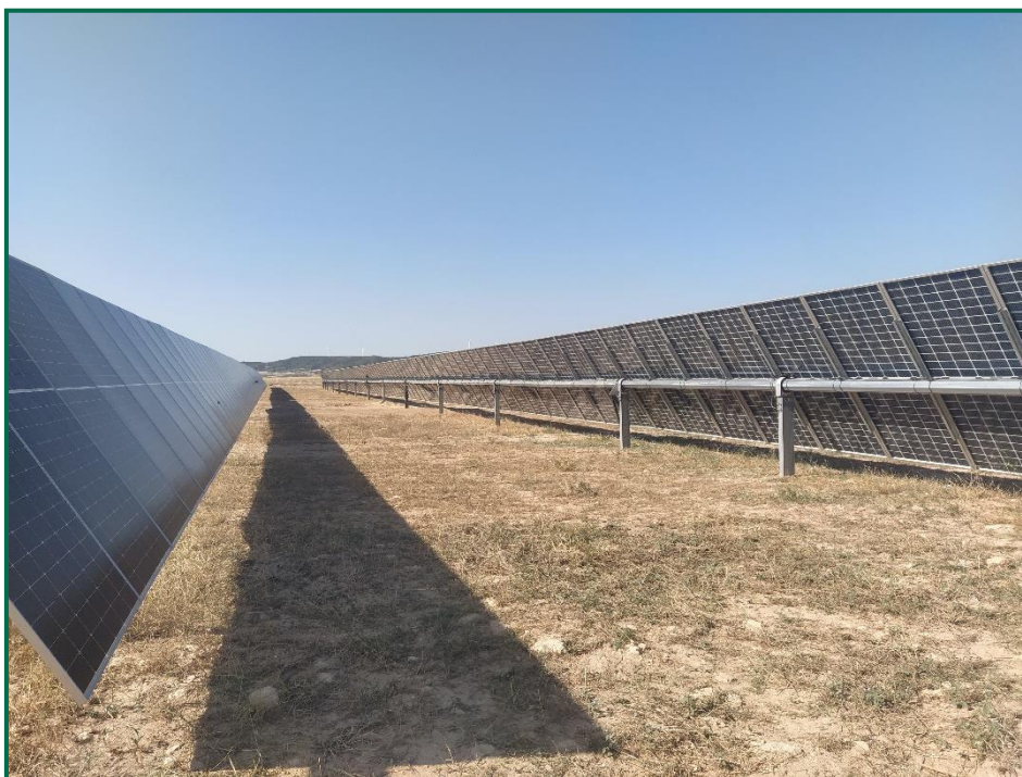
Fotografía 5. Hincas sobre el terreno.
